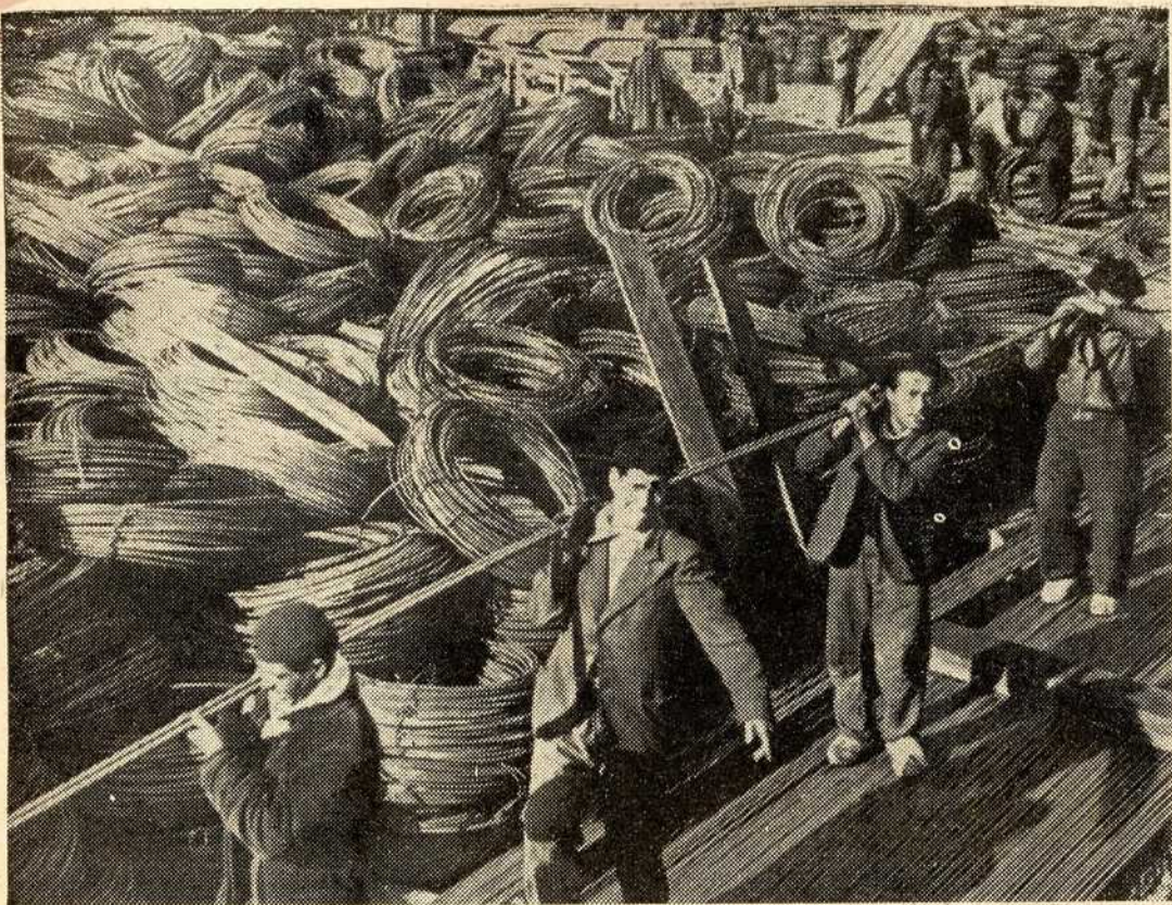
Огромна количина гвоздене жице и полуга потребна је за грађење бетонских склоништа за подморнице
