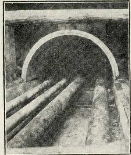
Канал са главним цевима за довод и одвод топле воде (Франкфурт).
