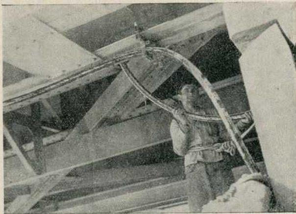
Полагање електричног кабла преко моста Краља Петра II
