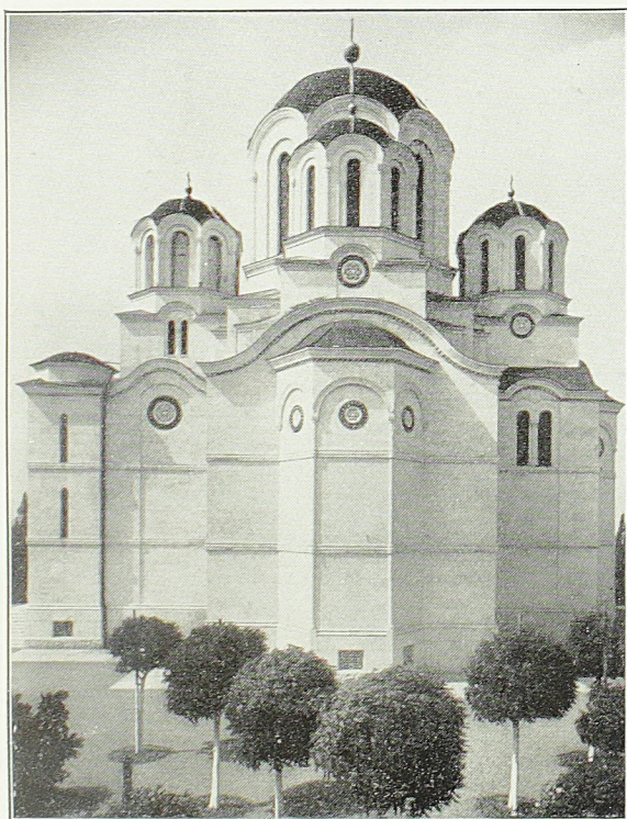
ИСТОЧНА ФАСАДА ЦРКВЕ НА ОПЛЕНЦУ
